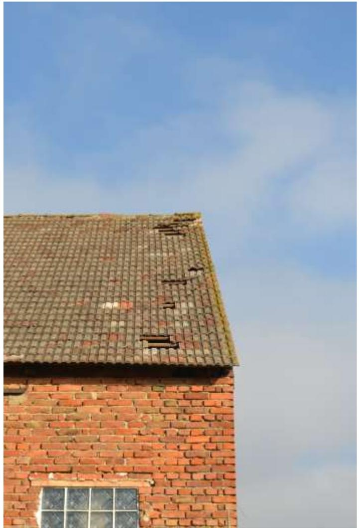
Am 28.07.2015, um 18:30 Uhr nach einem starken Wolkenbruch / Sturm bemerkte Kdt. Stv. Scheiner das sich bei seinem Stadldach einige Dachziegel gelockert haben, wodurch die Gefahr einer Dachabdeckung bzw. von Abdecken diverser Dachziegelstücke bestand. Demnach wurden die losen Dachziegelelemente entfernt und mit neuen Ziegeln wieder provisorisch eingedeckt.
